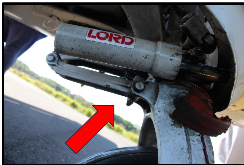
Fotografía No. 10 Amortiguador de nariz completamente vencido.
